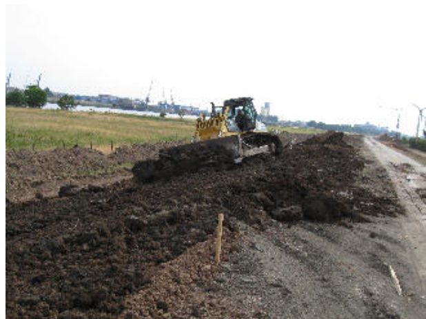
Deichbau, Profilierung der Lehmaddeckung
