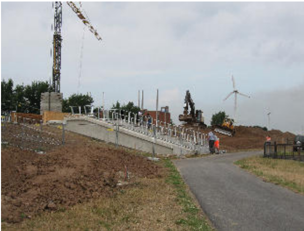
Deichbau, Anpassung des Auslaufbauwerkes
